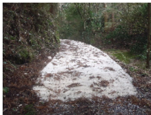
壊れにくい作業路網の例
