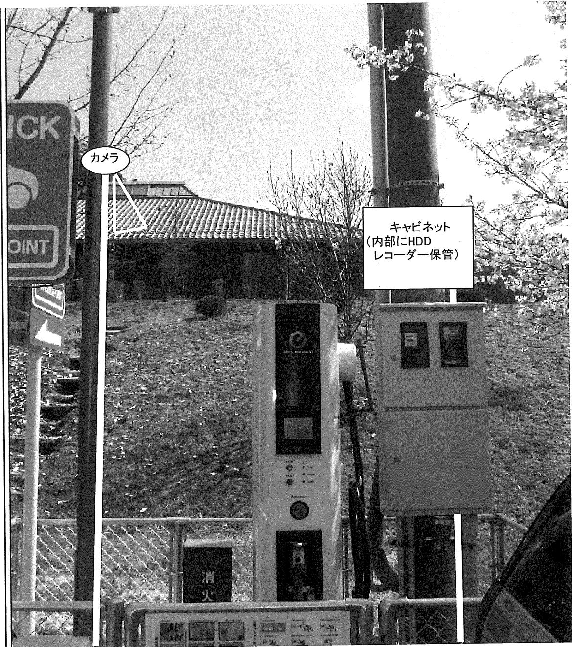
配電盤上部に キャビネットを設置し、その内部にHDDレコーダー、ブレーカ(カメラ用)を配置
