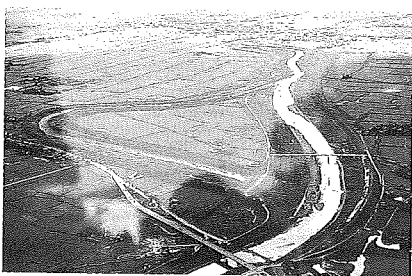
嘉瀬川改修 (ショートカット)
