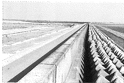
有明海岸堤防
