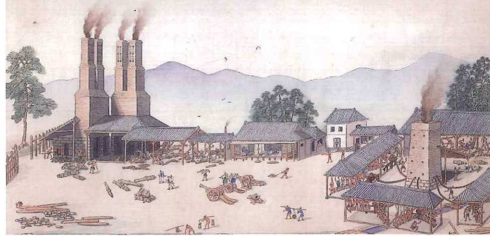
▲「築地反射炉絵図」(鍋島報効会蔵) 直正が鉄製大砲製造のために築地(ついで)今の佐賀市長瀬町)に作らせた日本初の反射炉。後に幕府からの大砲の注文に応えるため、市内の多布施にも作られた
