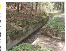
▲手前右の溝は必要以上の水を仕分けるための「のこし」
