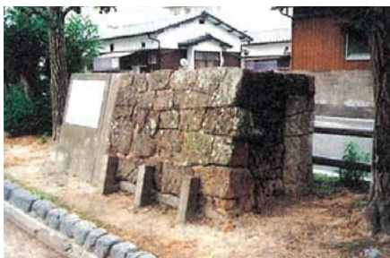
移設復元された石垣護岸
