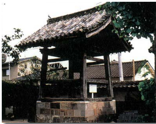
▲修理前の鐘楼
