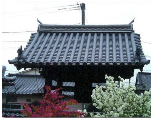
▲修理後の鐘楼屋根
