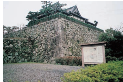
▲佐賀城天守台(平成13年頃の様子) (頂部の建物は明治建築の協和館 北東部から撮影)
