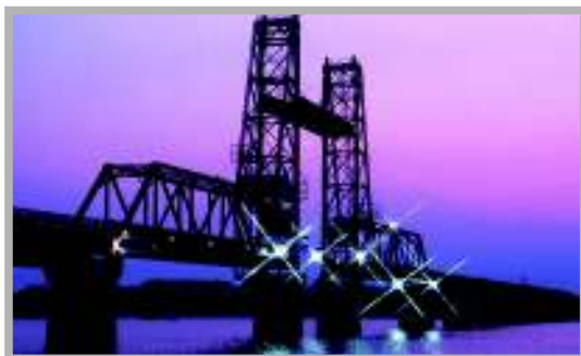
筑後川昇開橋
