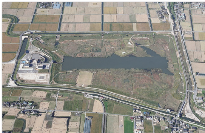
巨勢川調整池全景（保存地区）
