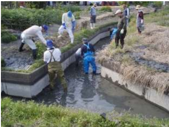
水路の泥土上げ
