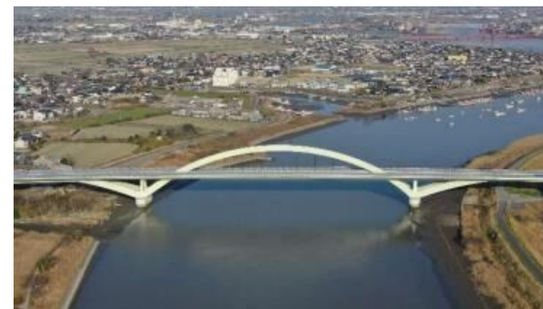
有明海沿岸道路の延伸
