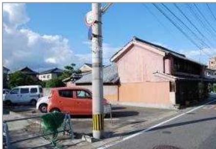
歴史的建造物隣接地 駐車場化の状況
