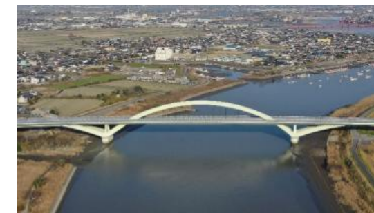
有明海沿岸道路の延伸
