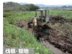
【粗放的利用のための条件整備】
