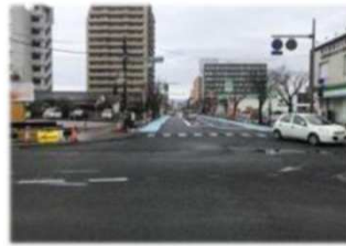
【道路整備の状況】
