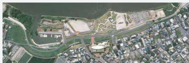
ドローン撮影による三重津海軍所跡全景
