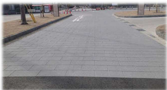
プリント舗装で施工
