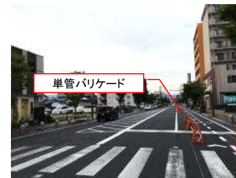
▲東側に自転車道を仮設
