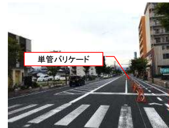
▲東側に自転車道を仮設
