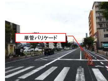
▲東側に自転車道を仮設
