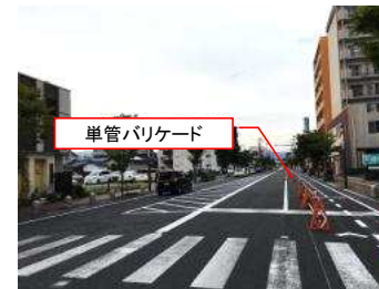
▲東側に自転車道を仮設
