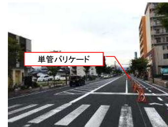
▲東側に自転車道を仮設
