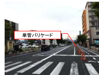
▲東側に自転車道を仮設
