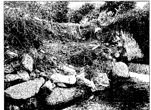
○河川災害(大和地区)
