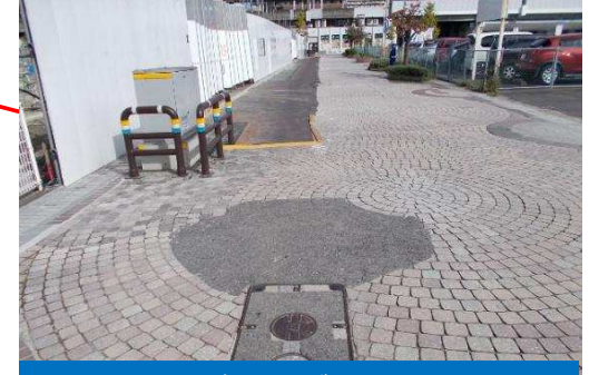
旧西友東側：ブロック舗装
