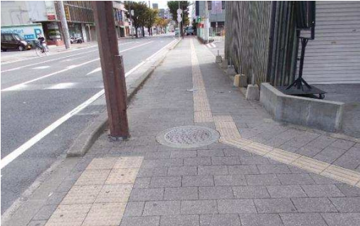
駅北通り：ブロック舗装
