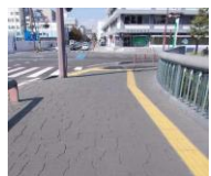
▲プリント舗装
