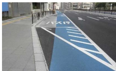
(東京都文京区:国道254号)
