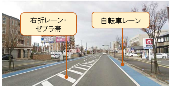
【参考事例】市道江頭西淵線(佐賀市兵庫北)
