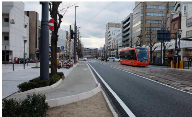
自転車道を設けることで歩行者空間と分離し安全性を確保
