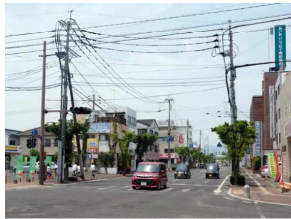
右折専用レーンが未整備の4車線道路
