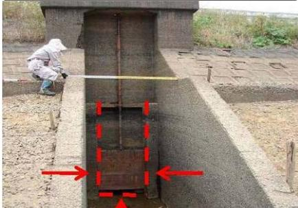
写真 34：取水部周辺の土砂やゴミの堆積
