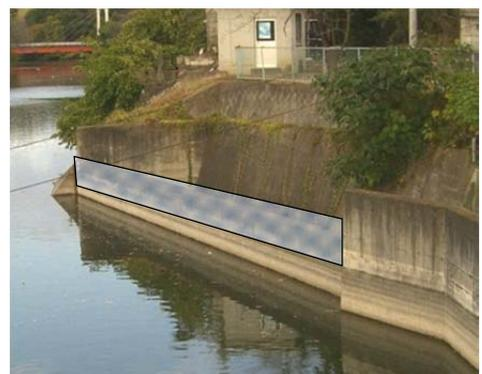
写真7：越流断面（青網掛け部分）
