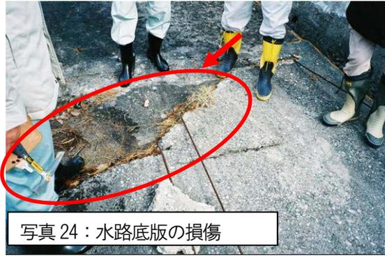
写真 24：水路底版の損傷
