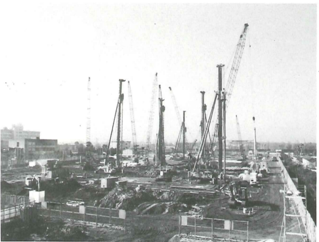
着々と進む総合文化会館建設工事
