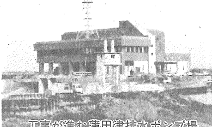
工事が進む蒲田津排水ポンプ場
