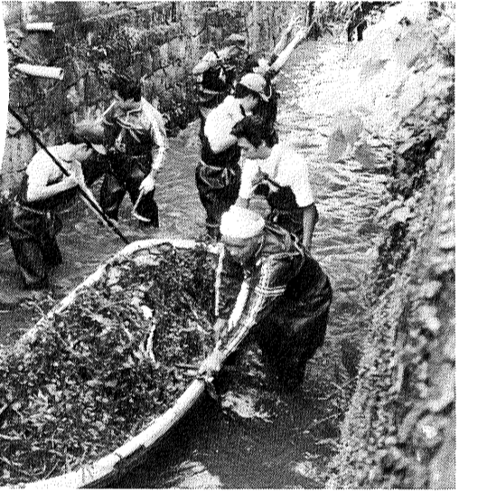
パンプリレーで泥上げ（俣野町）
