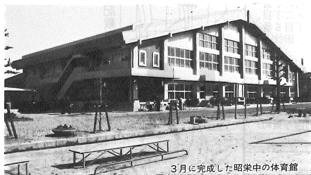
3月に完成した昭栄中の体育館
