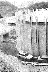
(完成した高所配水池)
