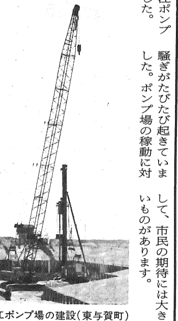
工事が進む八田江ポンプ場の建設(東与賀町)
