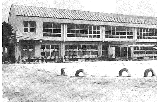
新築される西与賀小体育館と同型の若楠小体育館
