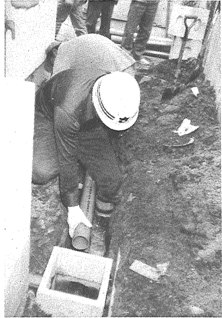
公共下水道への排水設備工事は指定工事店が行います
