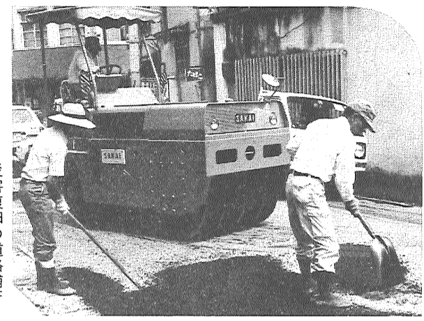
災害復旧の道路舗
