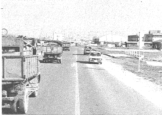
整備が進む都市計画道路(上多布施町・北島線)
