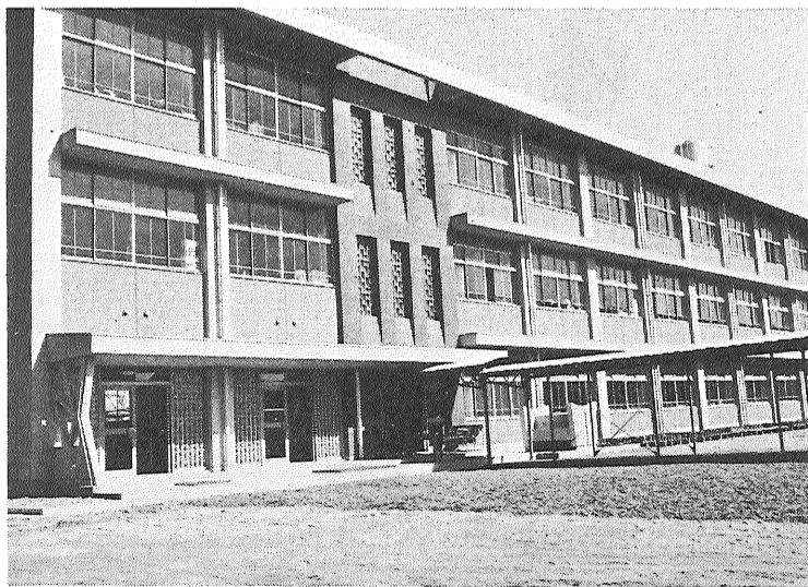
(S52. 2. 15. 第一期工事竣工)
