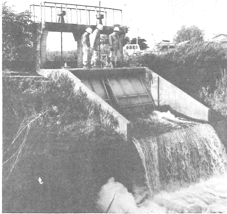
(樋門の管理も水災防止に重要な仕事)
