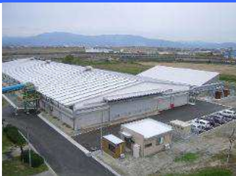
下水汚泥堆肥化施設（西与賀）
