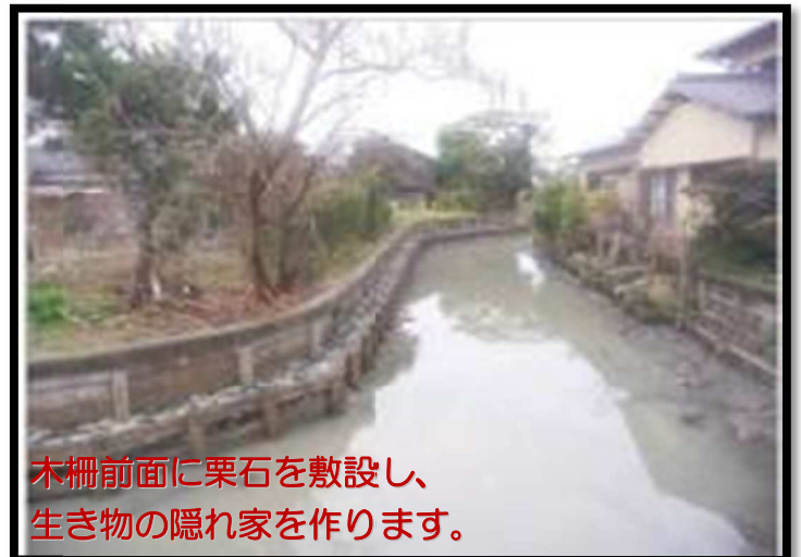
護岸にブロックを敷設すると、その隙間が生き物の隠れ家になります。
