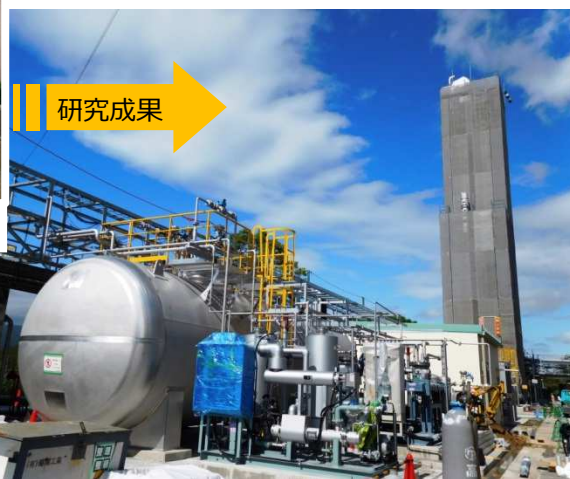
現在建設中の二酸化炭素分離回収設備（日量 10 t）
