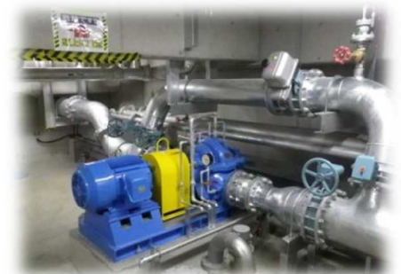
[写真] 清掃工場の小水力発電システム
