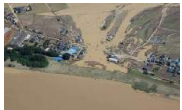
堤防決壊による家屋の流失(鬼怒川)
