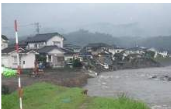
河岸侵食による家屋の倒壊(花月川)
