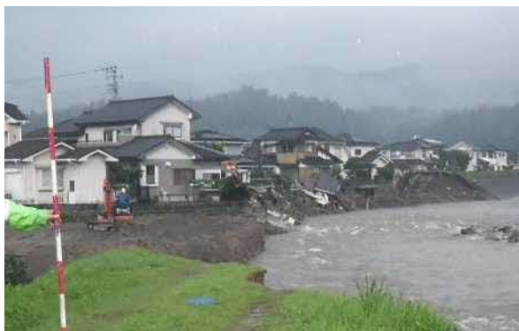
河岸侵食による家屋の倒壊(花月川)
