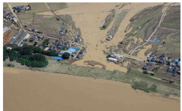
堤防決壊による家屋の流失(鬼怒川)
