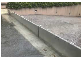
止水板の設置に手間がかかる
