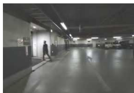
Point 身障者が安全に移動できる通路がない
