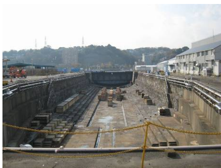
図 1: 現存する横須賀製鉄所ドライドック
