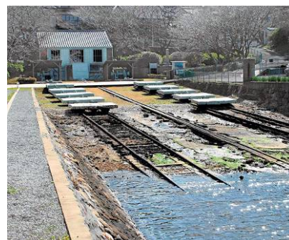
図 2: 現存する小菅修船場跡スリップドック
