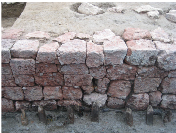
赤石護岸石積み状況（西側土橋部分）
