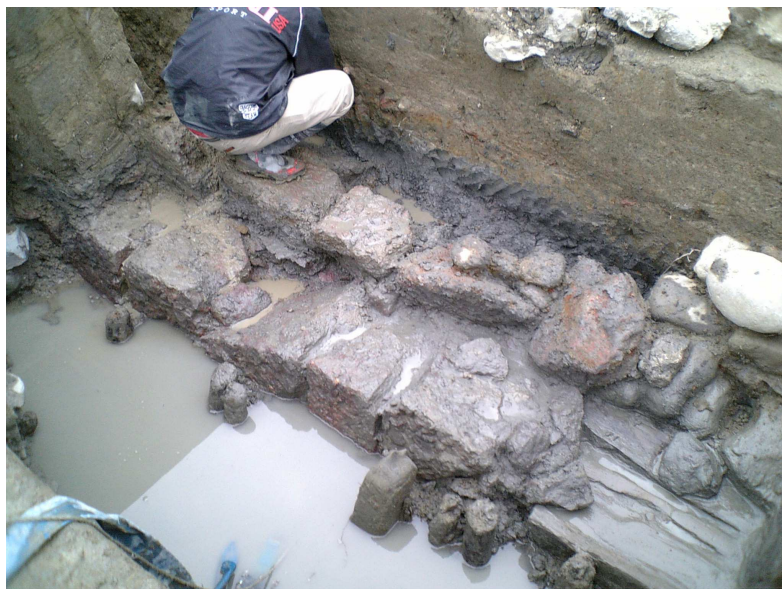
赤石護岸二重積み状況
