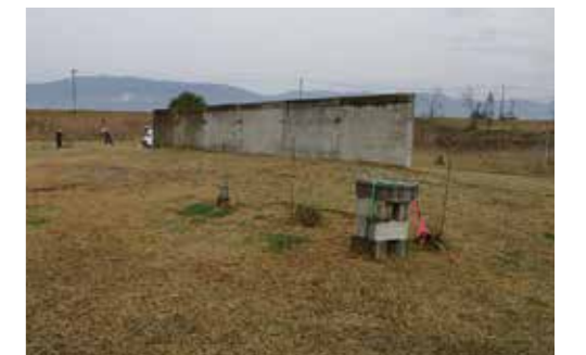
第4貝塚観測孔とL型擁壁
