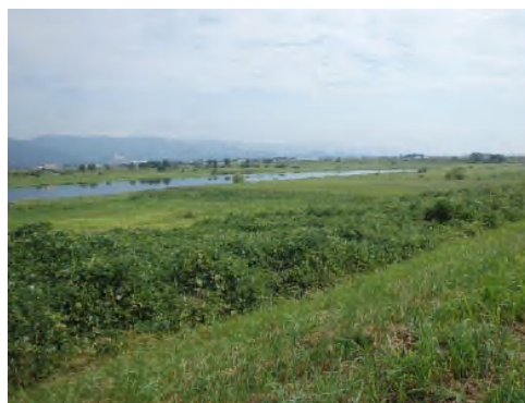
① 南西方向より
