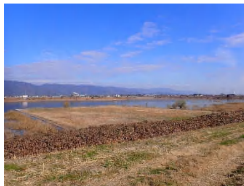
① 南西方向より
