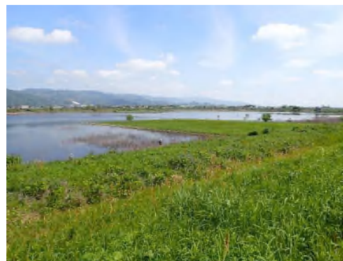
① 南西方向より
