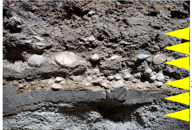
4 第1トレンチ; 地盤地業の様子（東から）
